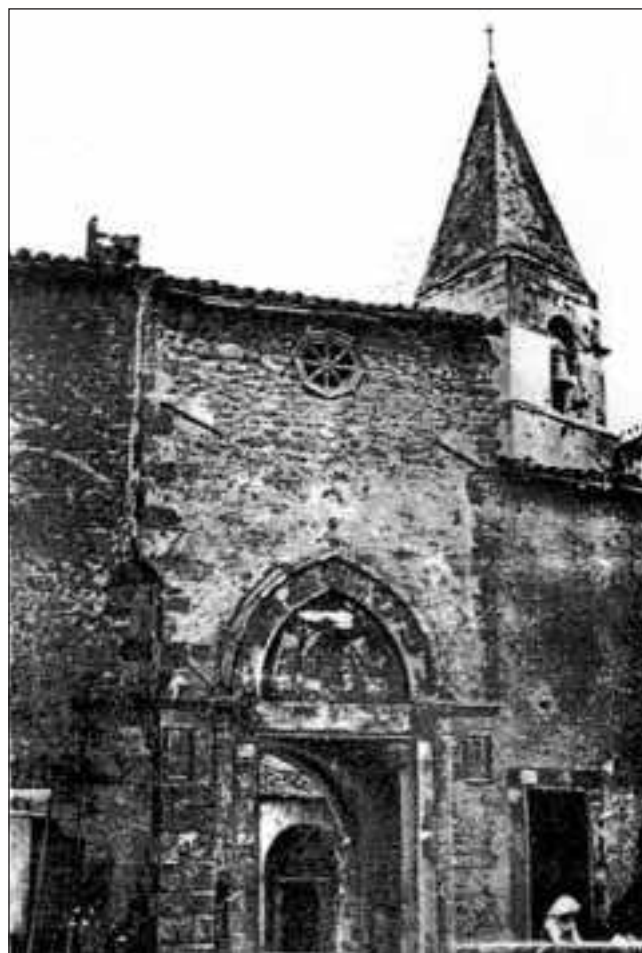
Fig. 7 - Il portale d'ingresso all'atrio delle donne in un'immagine antecedente il sisma del 1915 (da archivio privato)
