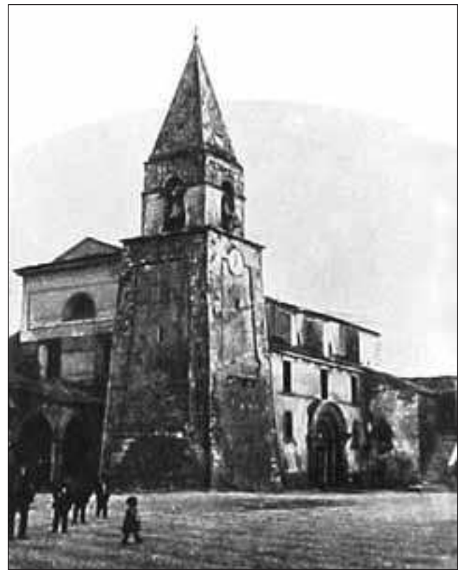
Fig. 8 - La basilica prima del sisma del 1915, sono visibili la cuspide del campanile, la terminazione quadrata della facciata ed il matroneo al di sopra della navatella di destra (foto da archivio privato)
